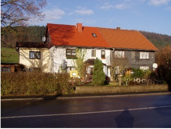
Erstes Schulgebäude (Ortsstr. 4a/4b ehemaliges Schaf- und Gemeindehaus)
